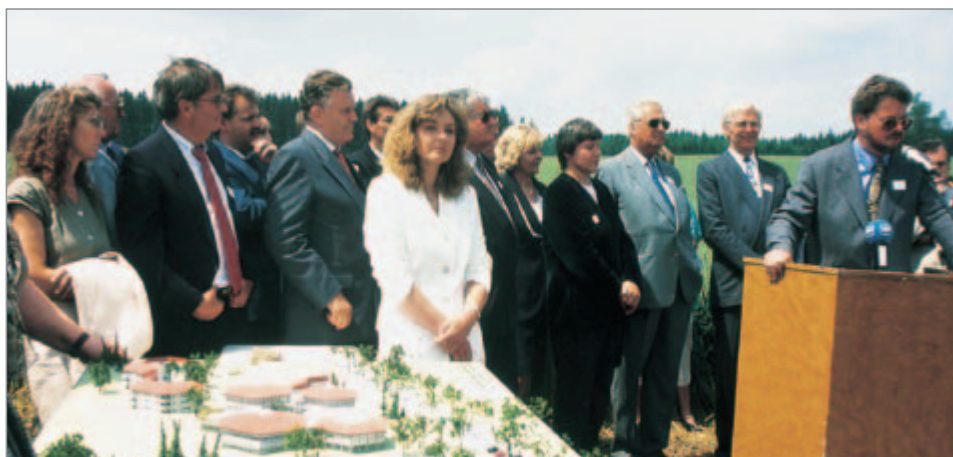
Die neue Klinik als Modell, viele prominente Gäste begleiteten den ersten Spatenstich der Nachsorgeklinik Tannheim am 6. Juli 1995. Am Rednerpult Geschäftsführer Roland Wehrle.
